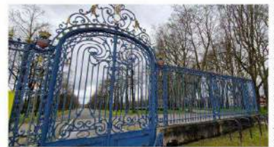
Les grilles manquent depuis 30 ans l'entrée du parc de la Hotoie.
